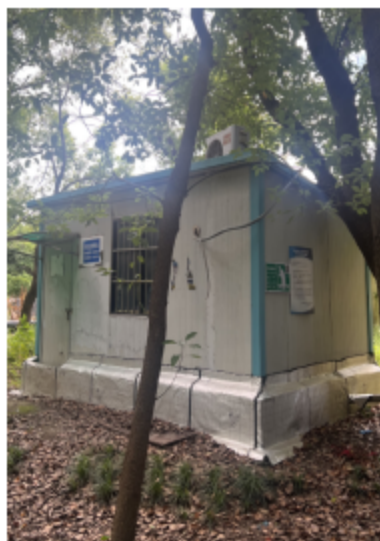
DW003 雨水排放口
