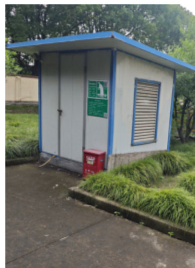
DW004 雨水排放口
