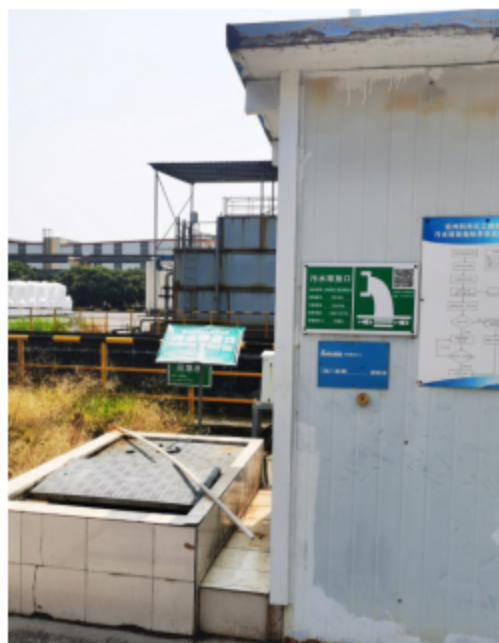
DW001 污水排放口
