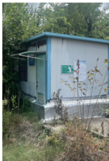
DW002 雨水排放口
